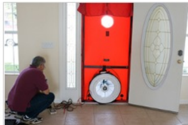
Home air leakage test in progress. (N. Waters)
